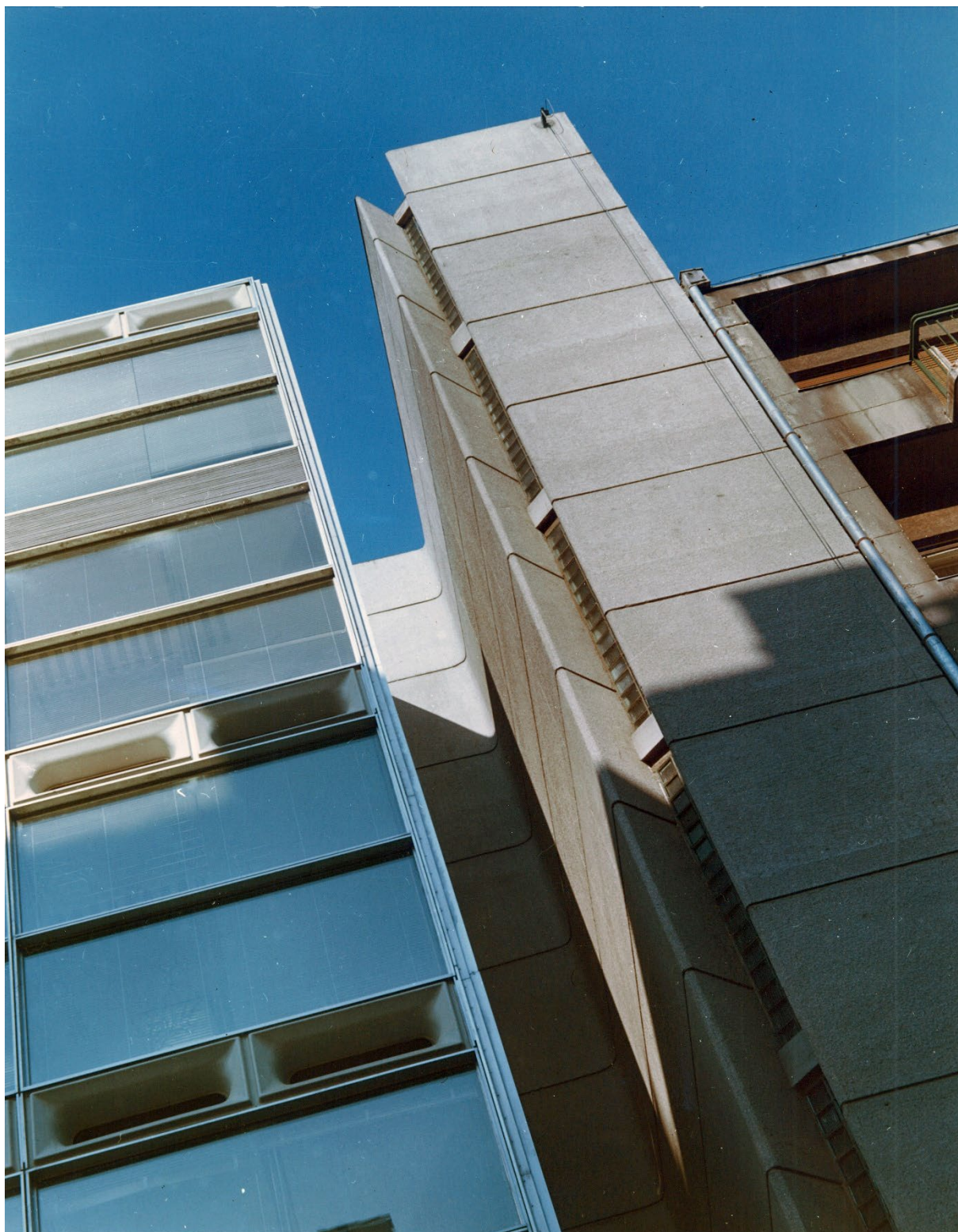
25.kép. Medicor. A Röntgen utcai lépcsőház részlete, „kapart” műkő felület, üvegtégla betét.
